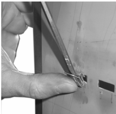
Abbildung 5: Einstecken des Snap-On-Clip
