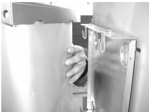
Abbildung 9: Montage des Öltanks
